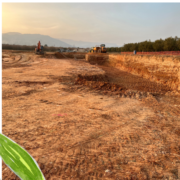
Inici de les obres al Gener
