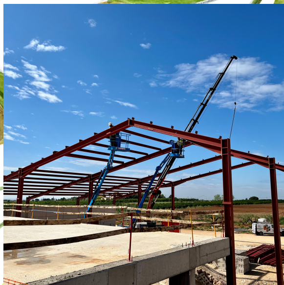
Estat actual de les obres
